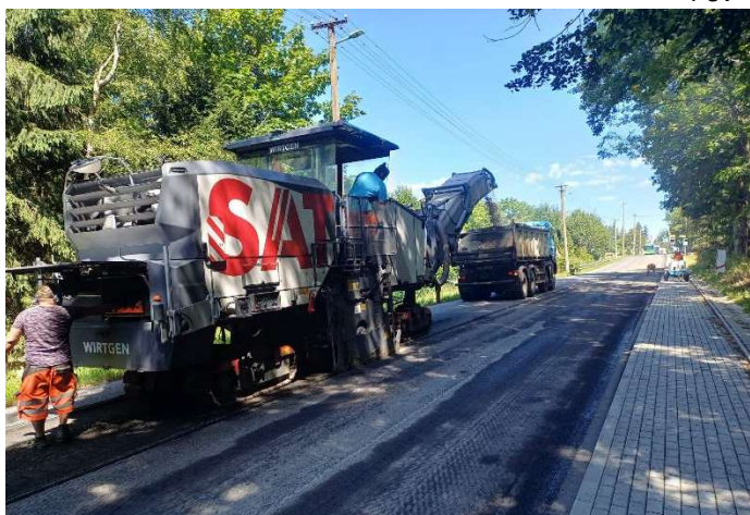
Foto FB Jiří Sucharda při zahájení stavby
