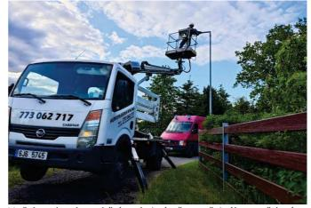
V těchto dnech probíhá v obci výměna veřejného osvětlení za LED technologii. Akci realizuje firma Elektronorth z Prysku za 1,7 mil. Kč, nová světla se montují na stávající výložníky (kromě těch podél hlavní silnice nebo těch ve špatném stavu). Zároveň bude nastavena nižší intenzita svícení v noci.
