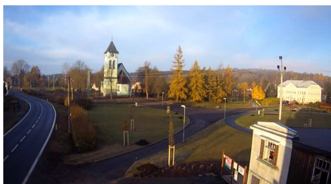
Aktuální snímek z 3.11.2021 naší návsi. Byla osazena nová svítidla. Dokončují se výsadby stromů a terénní úpravy ploch.
