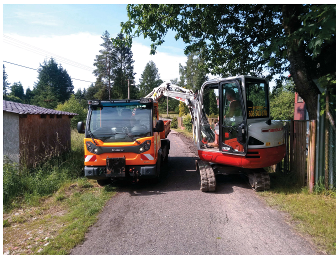
Na stavbě se mimo najatý bagr podílí i naše technika a ...
