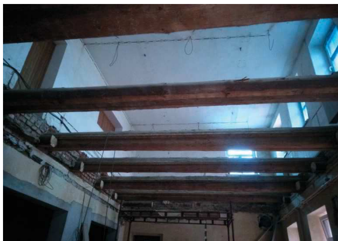
Současný pohled z lokálu na „strop“ – mezi trámy je střecha.
